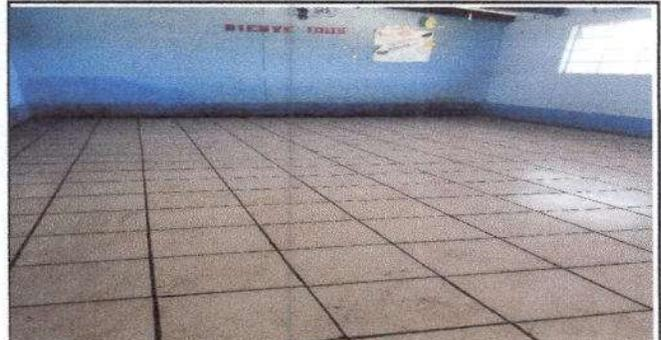
Foto 2: Sustitucion de torta de cemento por piso cerámico
